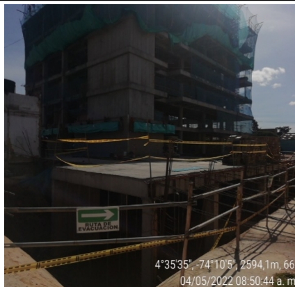
Fotografía 3. Construcción edificio sede sur UNIMINUTO
