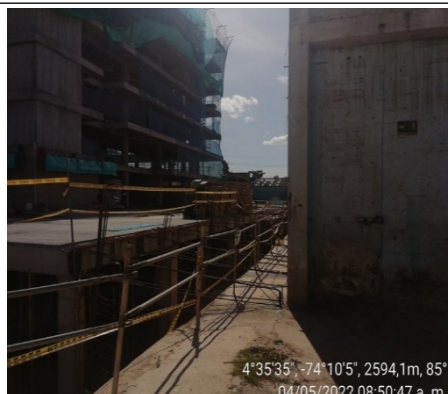
Fotografía 2. Construcción edificio sede sur UNIMINUTO
