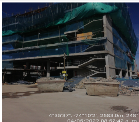
Fotografía 1. Construcción edificio (10 pisos) sede sur UNIMINUTO
